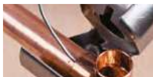
Пайка медных труб (только HG651C, HG551V)
