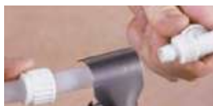
Монтаж пластиковых труб
